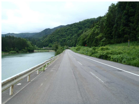
施工箇所（国道252号 水沼地内）
