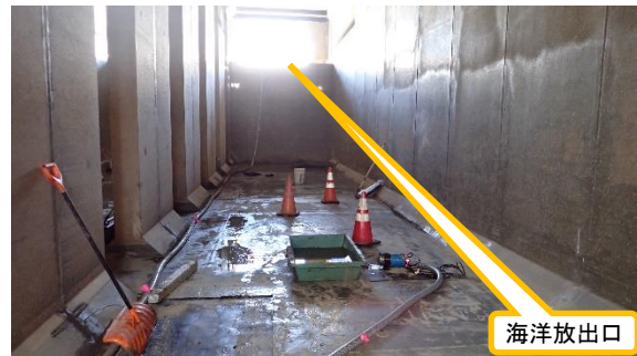
(写真1②) 上流水槽内部
