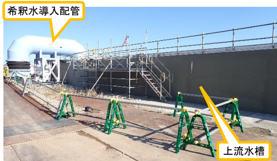
(写真1①) 上流水槽外観
