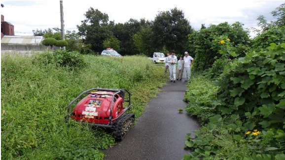
【①ラジコン式草刈機での草刈り作業】
