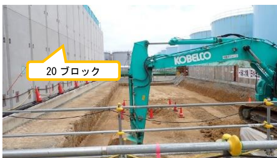
(写真3) 21ブロック目設置箇所の基礎工事の 状況
