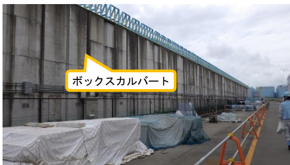
(写真1) 使用済セシウム吸着塔一時保管施設 (第三施設)の概観
