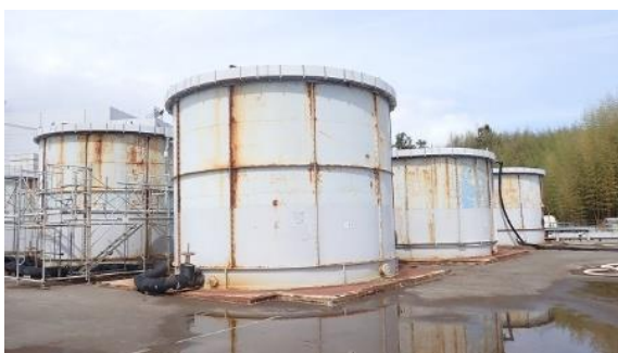
(写真1-1) F2タンクエリアの概観 C群タンク
