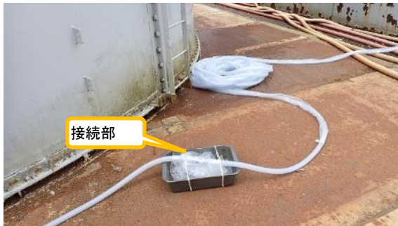
(写真6) 仮設ホース接続部の状況
