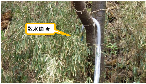
(写真5-2) 仮設ホースによる散水状況②
