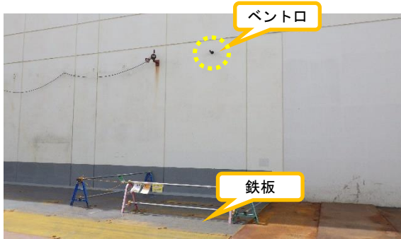
(写真5) HT I 建屋東側のベント口及びその 周辺の状況
