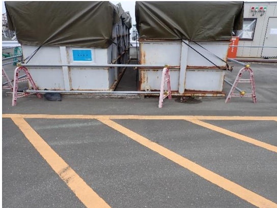
(写真2-2) 防火水槽の設置状況
