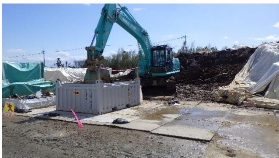
(写真2) 汚染土壌の詰替の状況
