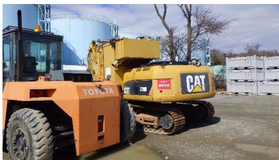
(写真4-2) エリアA2から移設された重機の状況
