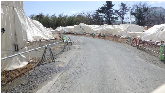
(写真1) 一時保管エリアE1の状況
