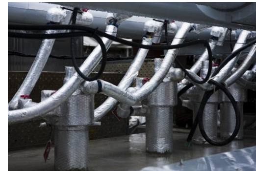
陸側遮水壁 凍結管
