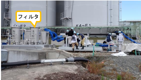
(写真2) K4タンクエリア南側におけるフィルタ等設備の設置作業状況
