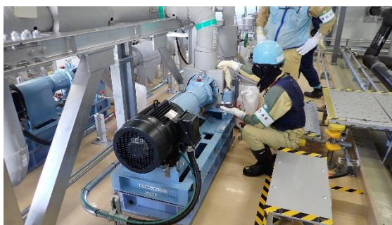
(写真2) 処理水移送ポンプ（B）起動後の状 態確認の状況
