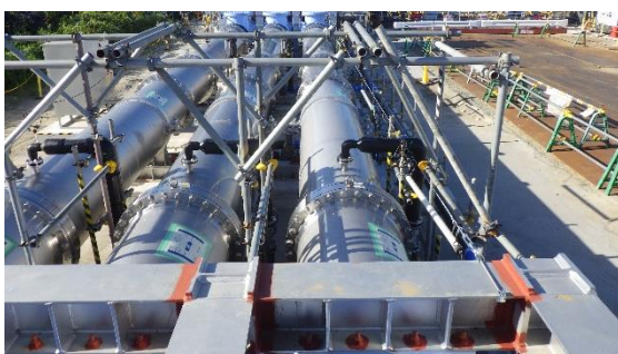
(写真2-3) 海水配管の状況
