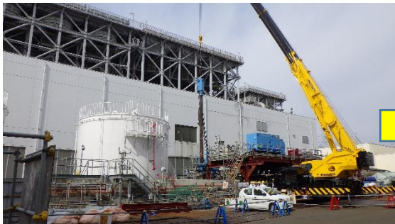
(写真1-1) 鋼矢板設置場所周辺の概観① (前回(3月1日)南東側から撮影)
