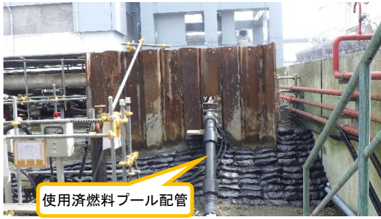
(写真 2 - 2) 鋼矢板の設置状況② (西側から撮影)
