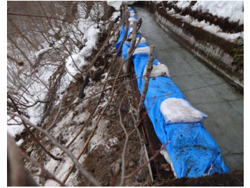
崩壊した法面を応急補修
