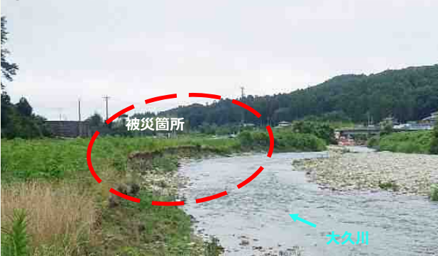
②大久町大久字助塚地内 【施工前】
