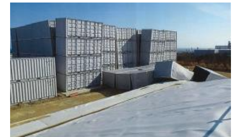
瓦礫保管エリア一時保管施設での コンテナ傾き及び転倒
