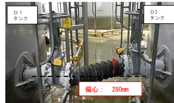
連結管(D1-D2間) (堰内は少量の雨水が滞留)
