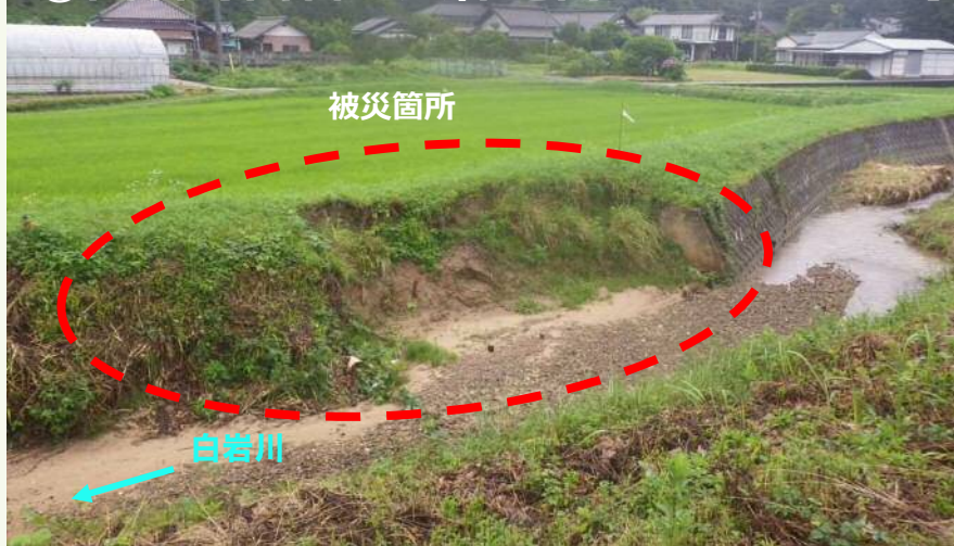
② 四倉町白岩上大作地内 【施工前】
