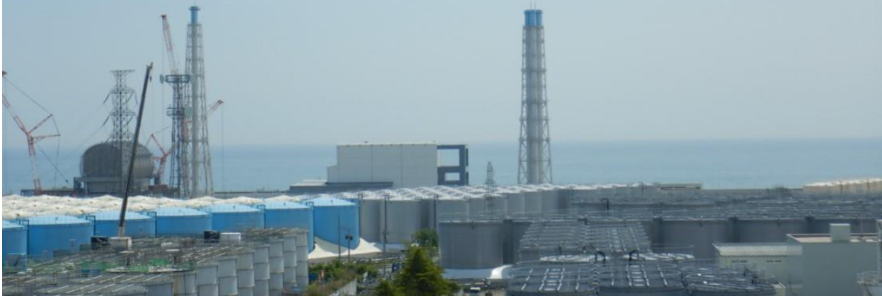
処理水を貯蔵しているタンク群
