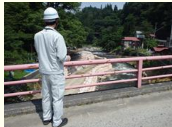
河川工事状況の巡視
