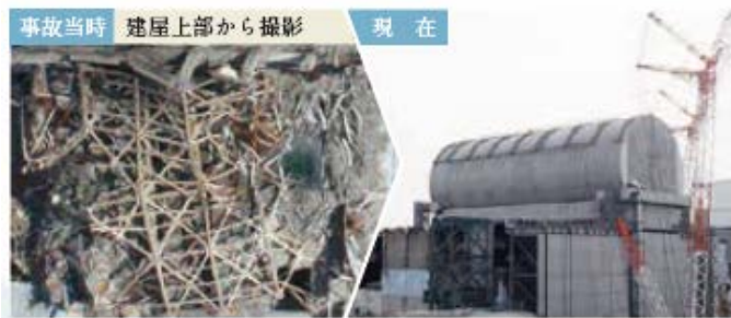
<参考> 3号機の状況(左：事故当時、右：現在)
