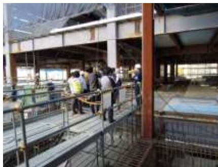
初めて間近で見る工事現場
