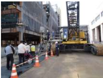
教室から見ていた工事現場へ！
