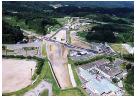
磐越自動車道・あぶくま高原自動車道（小野町）
