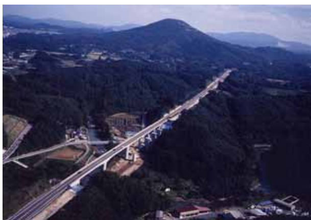
磐越自動車道4車線化工事
