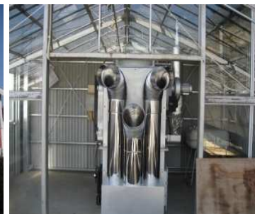
ペレットボイラー設置（温室内2011/2/22）
