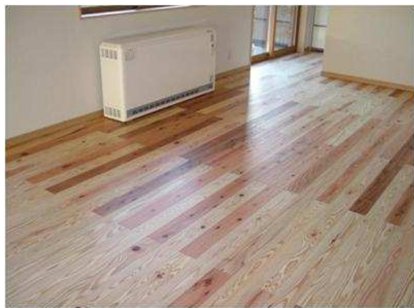
フローリング施工例
