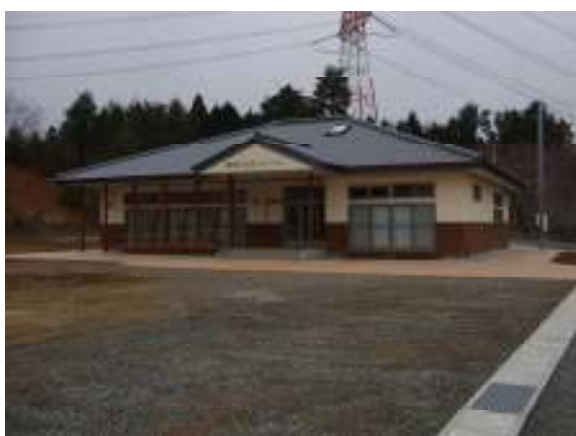
活性化施設整備「論田ふれあいセンター」
