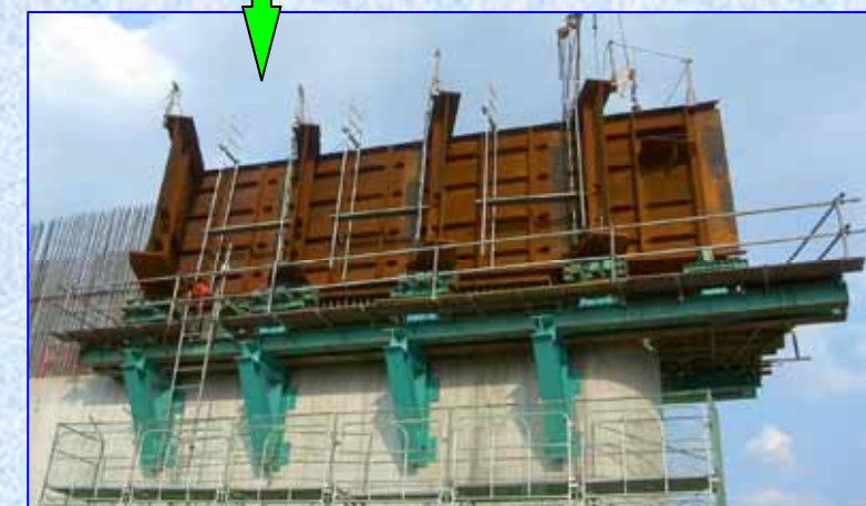
中間支点部での作業状況
