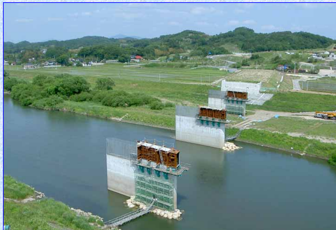
架設時の状況 A 1 側から A 2 側を望む (2007 年 5 月現在)
