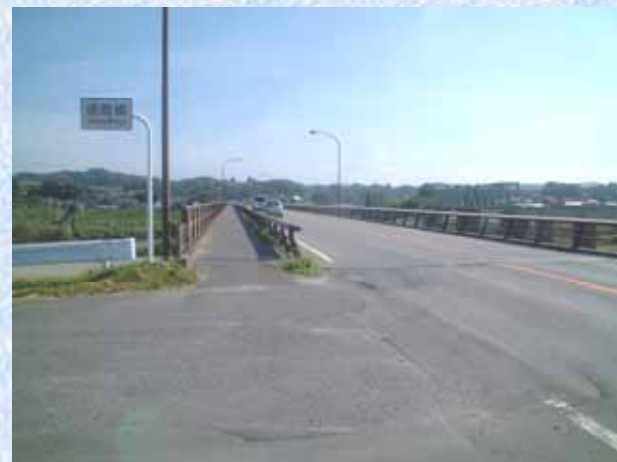
一般国道 288 号 逢隈橋
