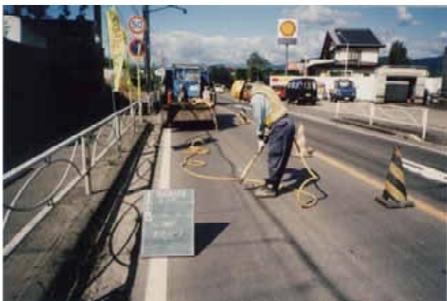
図 4-4 シールコートの施工中、竣工状況
