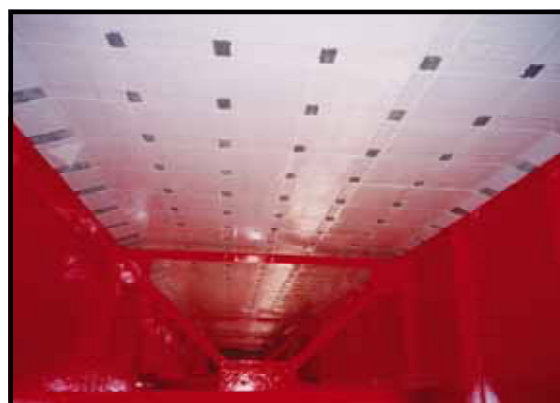
図 4-2 炭素繊維接着工施工前・施工後（国道 118 号大平橋）
