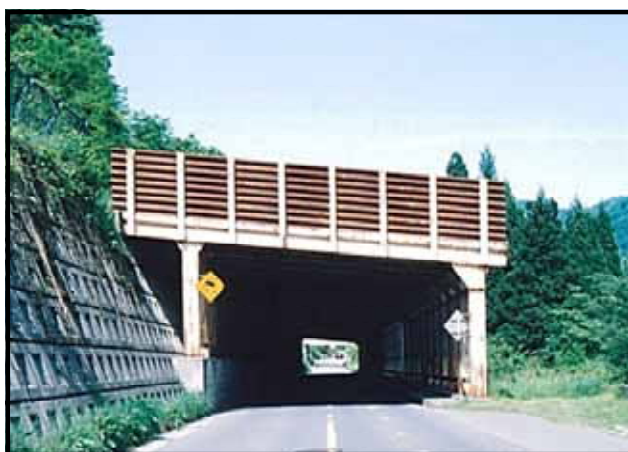
図2-13 国道252号 (本名第2スノーシェッド)
