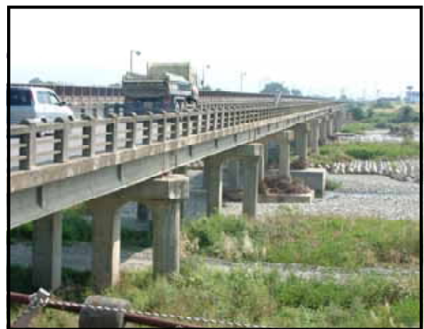
図2-4 (主) 会津若松三島線 (蟹川橋 昭和30年完成)
