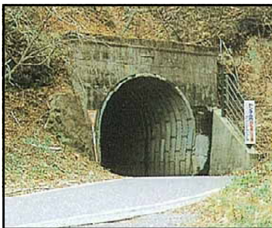
図2-9 (主)白河羽鳥線 (羽鳥隧道 昭和18年完成)
