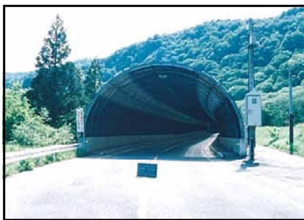
図2-14 国道252号 (滝第2スノーシェルター)
