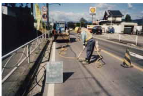
シールコートの施工中、竣工状況
