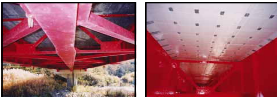
炭素繊維接着工施工前・施工後（国道118号大平橋）
