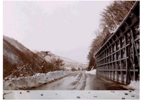
▲落石防護施設工 国道352号 (田島町滝原)
