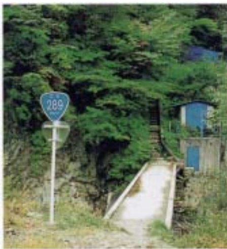
国道289号交通不能区間の状況
