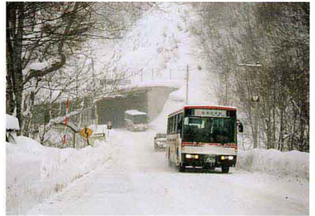
国道352号(館岩村 数間沢スノーシェッド)
