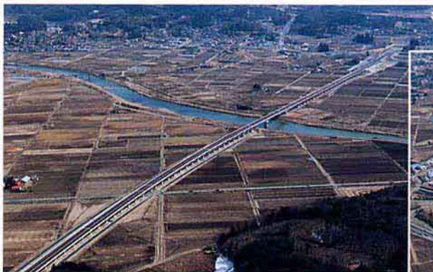
うつくしま大橋 (橋長1,259m 県内の道路橋長1位)
