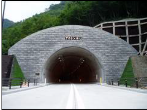
甲子トンネル
