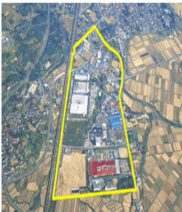
上空から見た桑折工業団地
