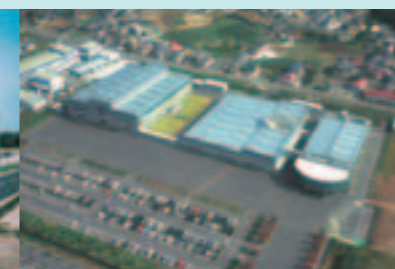
▲電力機械器具製造工場(須賀川市)
