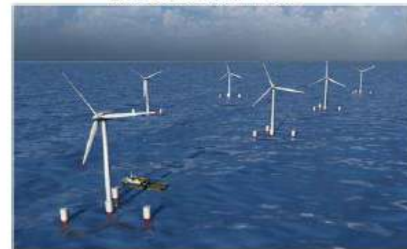
浮体式洋上ウィンドファームイメージ (提供:三井造船(株)、東京大学、東京電力(株))
