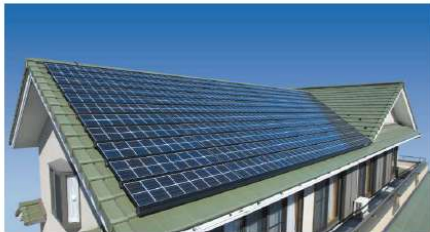
<住宅用太陽光発電システムを導入した住宅の例>
