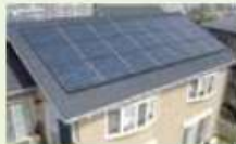
太陽光パネル
