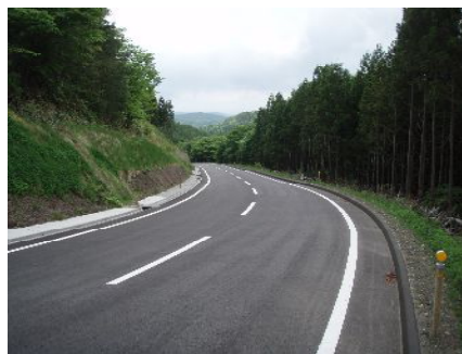
林道開設事業での間伐材利用（法面保護工）
